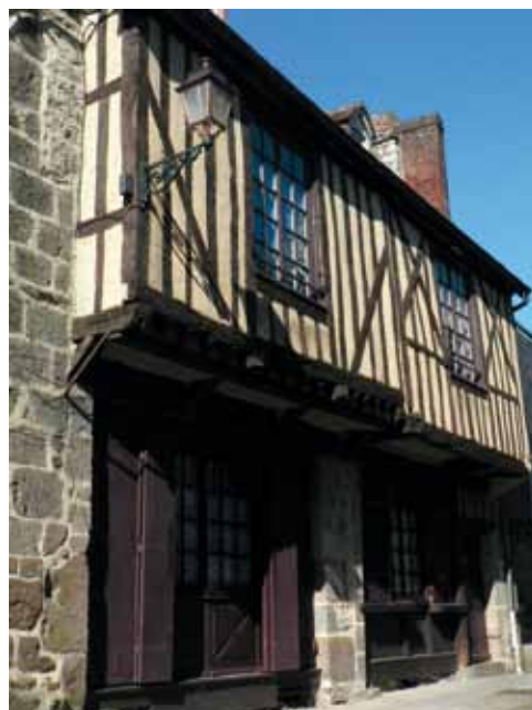
Vieille maison xv^e siècle avec anciennes boutiques au rez-de-chaussée, au 38, rue du Docteur-Barrabé.
