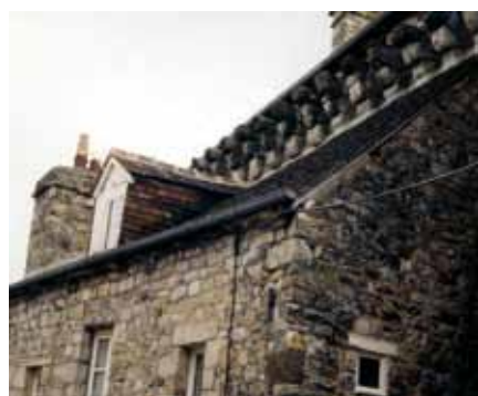
Maison construite contre le rempart, rue de la Poterne. Les corbeaux subsistent au sommet de l'ancien mur d'enceinte.
